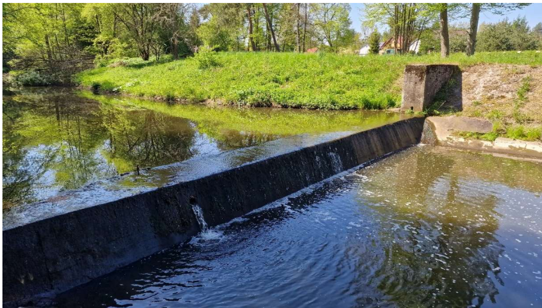
Fotografia 1: Przykład bariery na szlaku – próg wodny za jazem przy elektrowni Kolincz (rz. Wierzyca)
