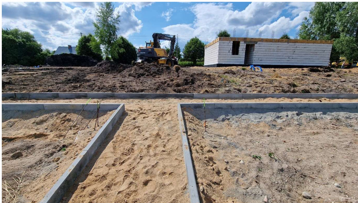
Fotografia 8: Realizacja pierwszego etapu budowy przystani kajakowej w Lipuszu (rz. Wda)
