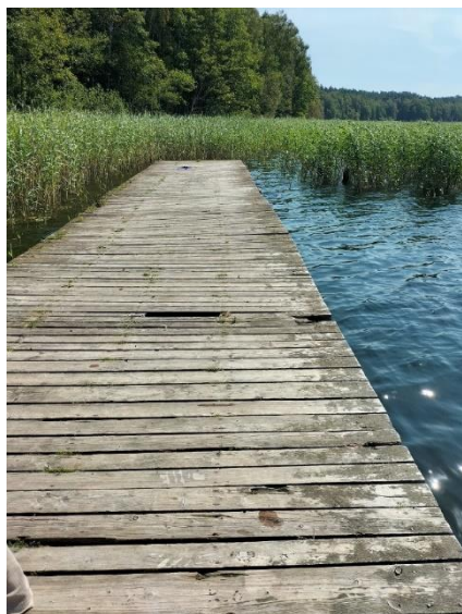
Ilustracja 1. Zniszczony pomost
