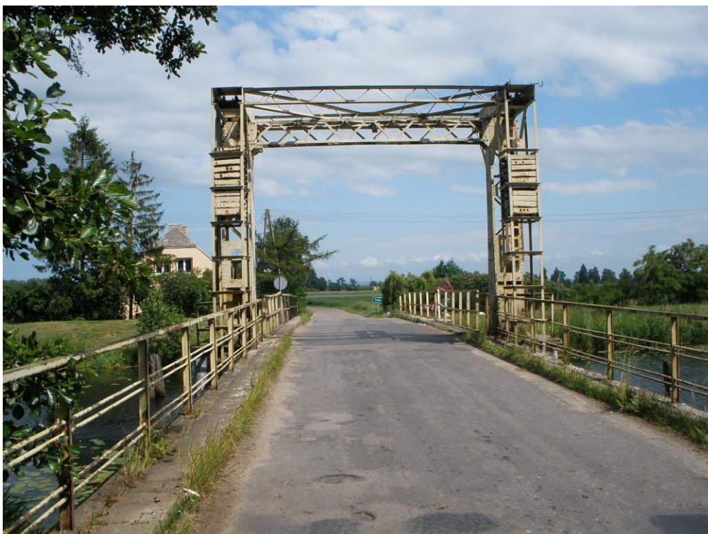
Rys. 4.1. Most w Tujsku – widok od strony drogi.
