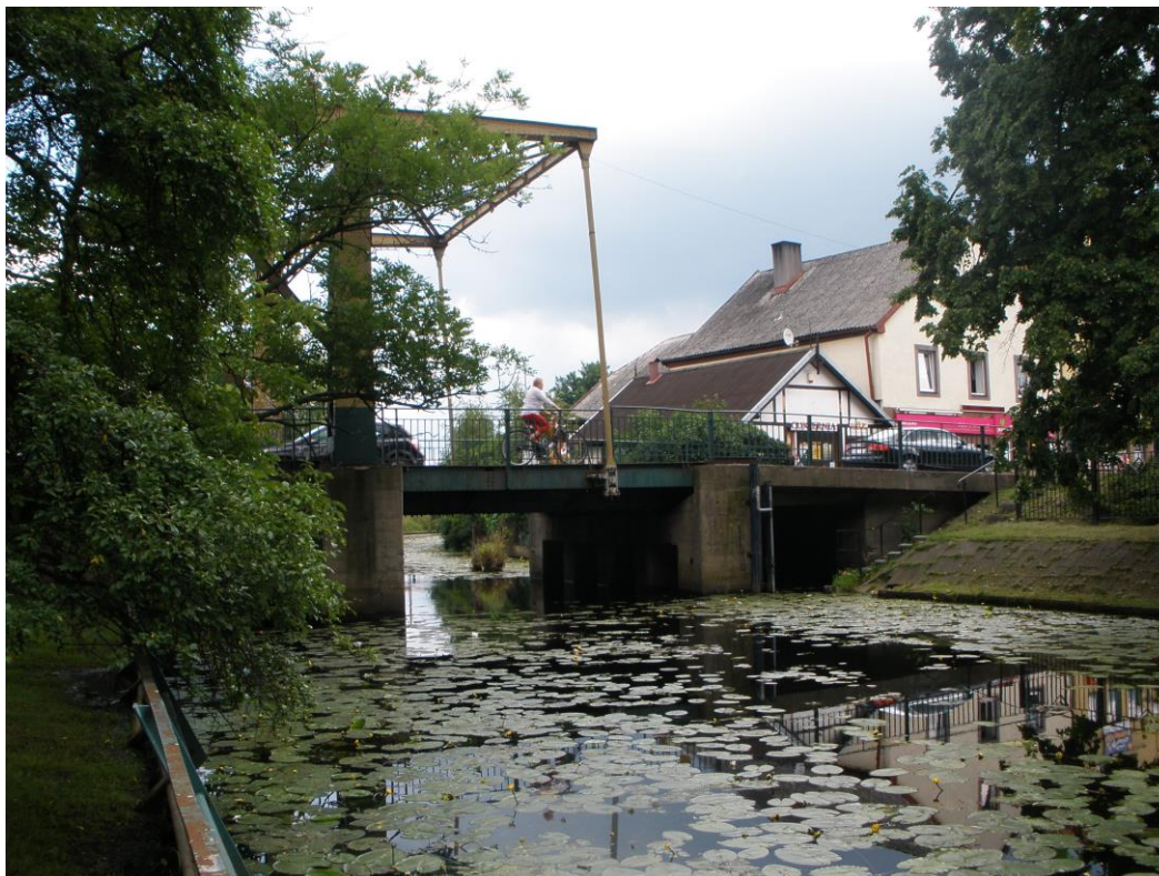
Rys. 6.1. Most w Nowym Dworze Gdańskim – widok od strony planowanej przystani.
