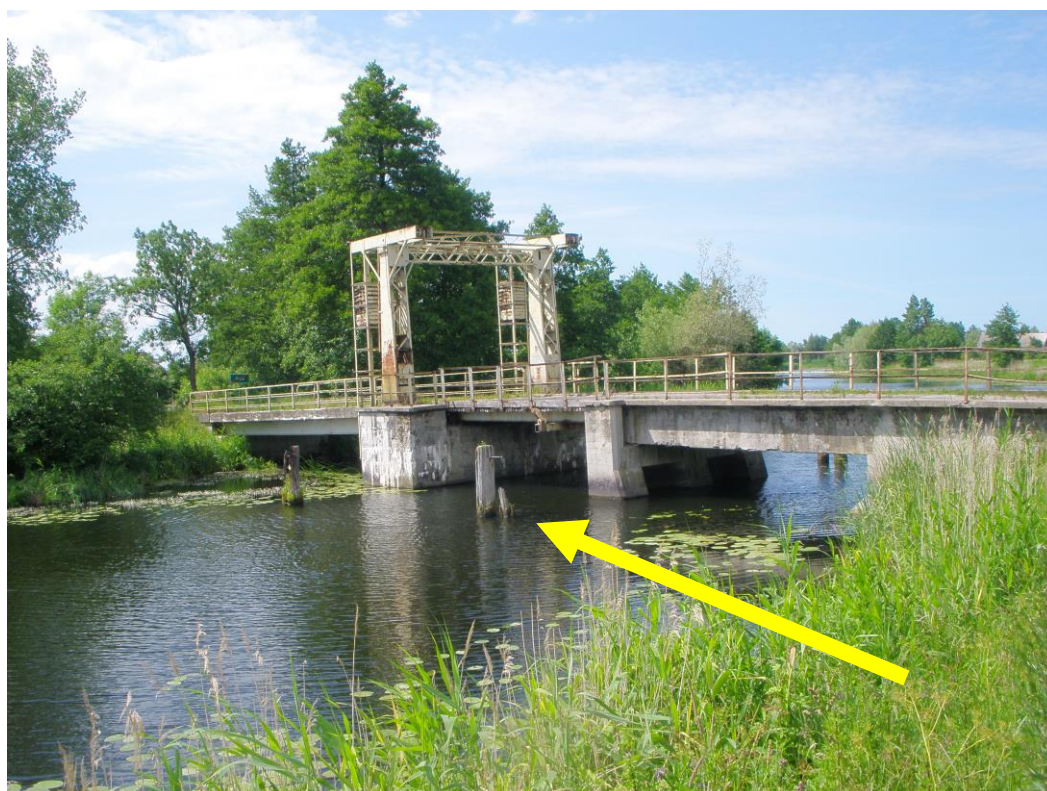
Rys. 4.2. Most w Tujsku –zdezastowane dalby stanowiące zagrożenie nawigacyjne.
