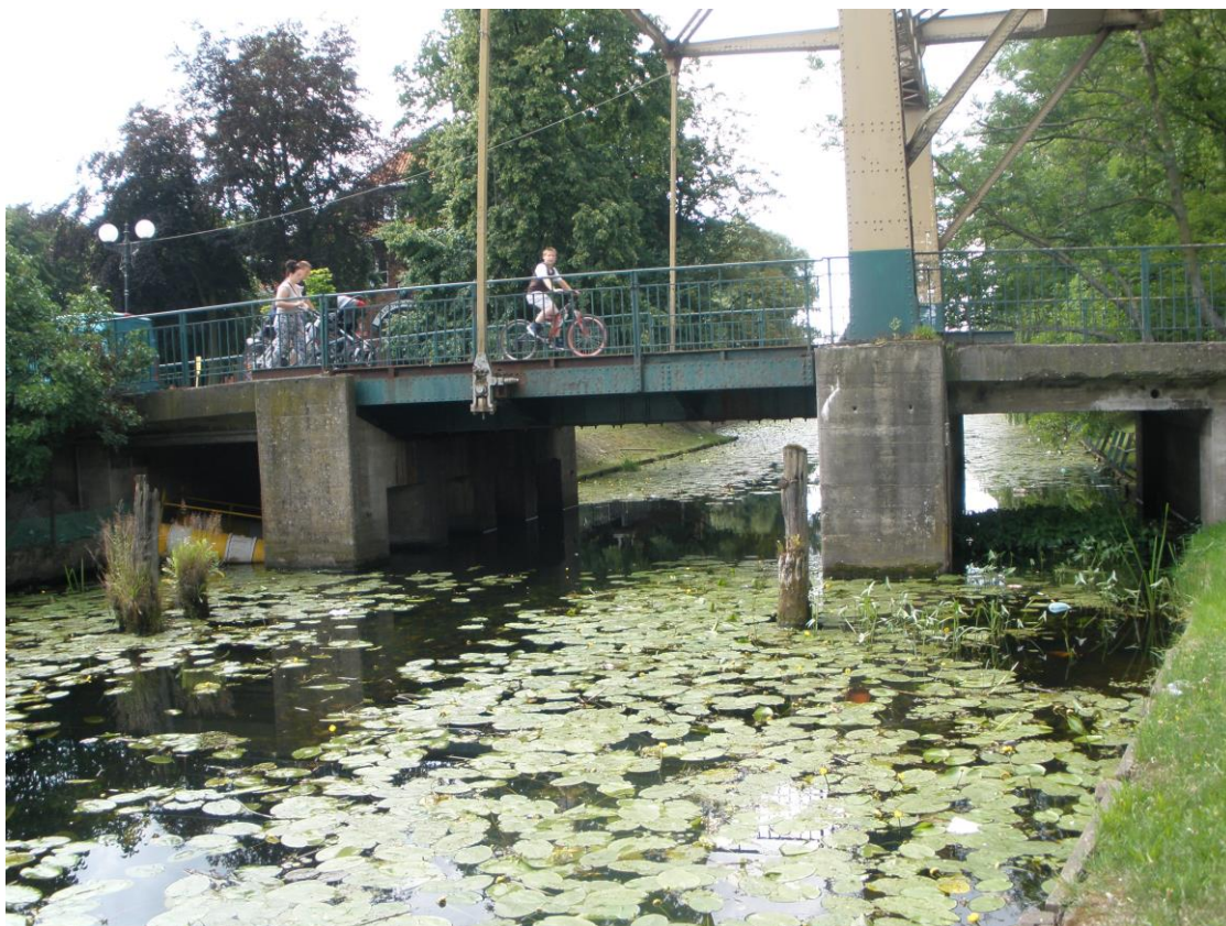
Rys. 6.2. Przejście pod mostem w Nowym Dworze Gdańskim – podejście od północy.
