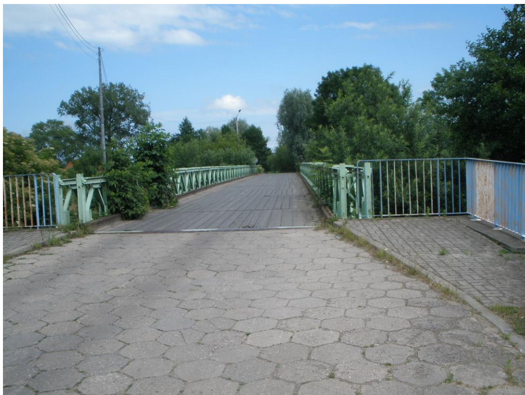
Rys. 5.1. Most w Żelichowie – widok od strony drogi.
