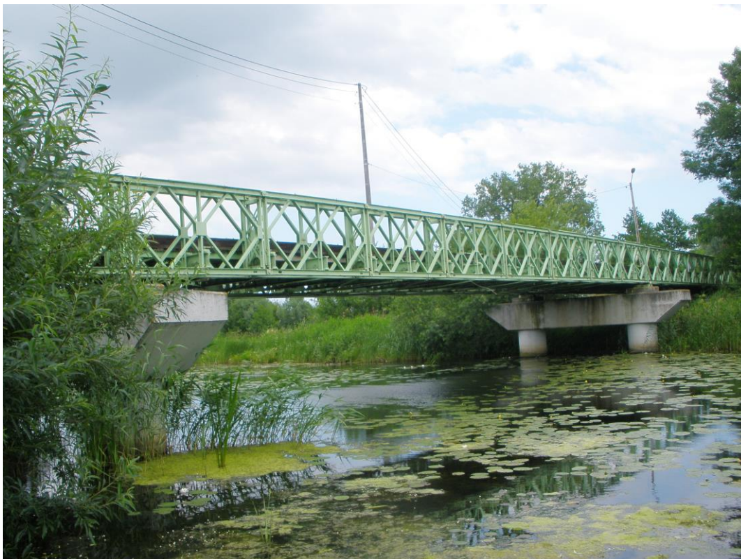
Rys. 5.2. Przejście pod mostem w Żelichowie i widok na linię napowietrzną.
