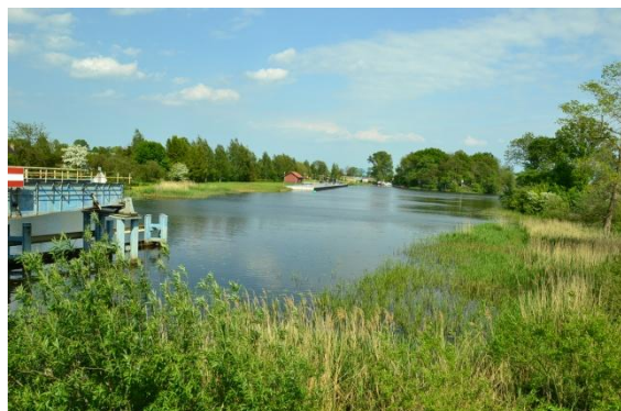
Fot. 7 Szarpawa, widok na fragment mostu obrotowego oraz nabrzeże w miejscowości Rybina
