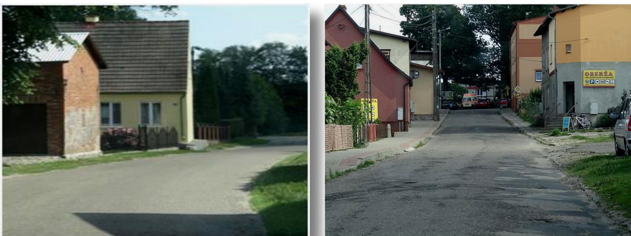
Fotografia 47: Odcinek w pasie jezdni drogi powiatowej do Gardny Wielkiej
